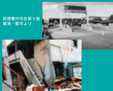
阪神淡路大震災時の豊中市での被災状況
