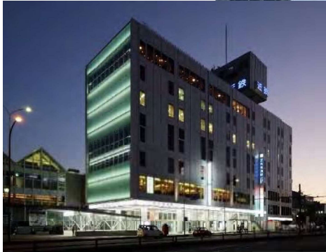
改修後外観（夜景）。東大寺や若草山方面からのアイストップとなる東面にガラスカーテンウォール採用
