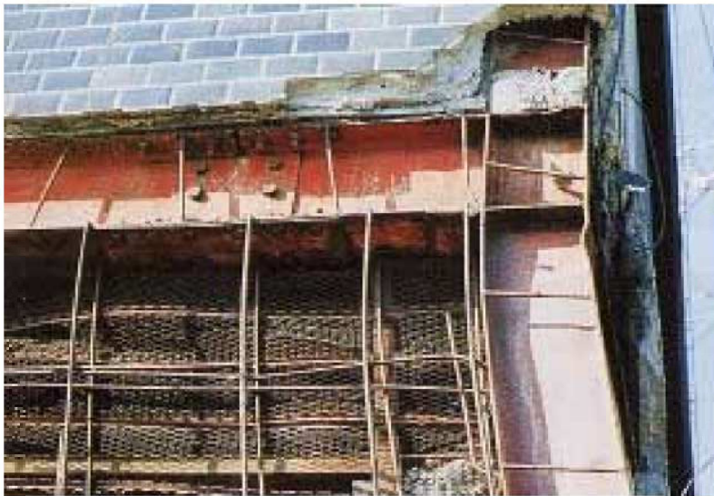
H形柱・H形梁 強軸方向曲げによる 柱頭部局部座屈
