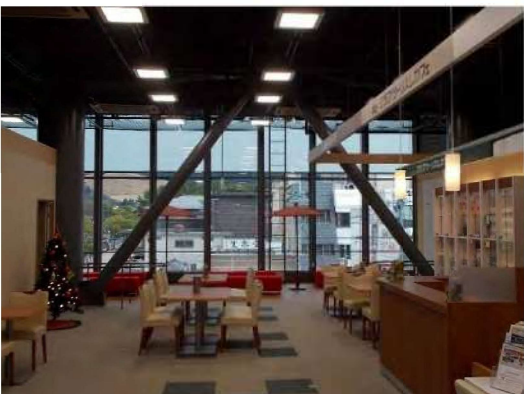
5階展示室部分への鋼管ブレース補強
