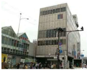
改修工事前の外観
